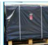
Składowanie i oznakowanie azbestu
